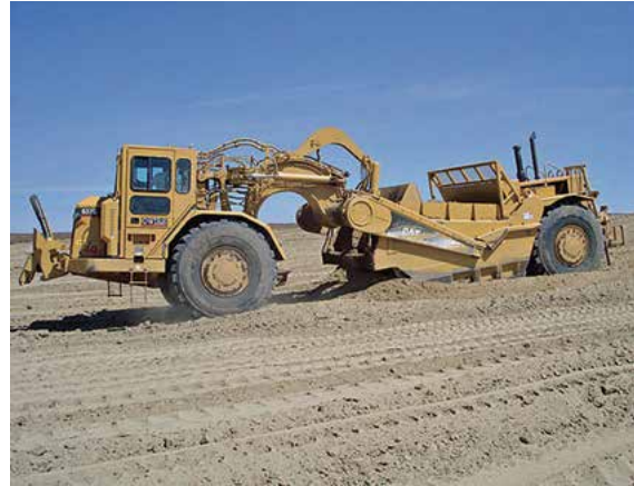
Слика 2. Равнање терена скрејпером
