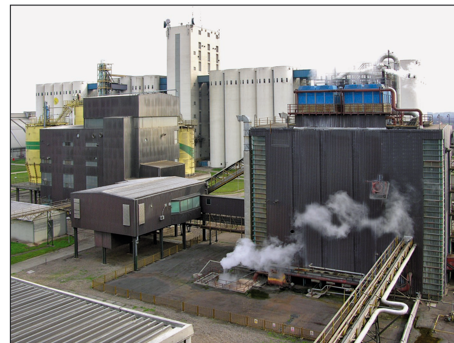
Pogon ekstrakcije i silos
