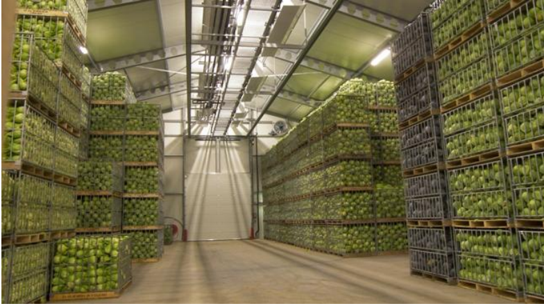
Slika 84. Hladnjača sa kontrolisanom atmosferom ( http://промхолд.рф )
