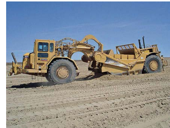
Слика 1. Равнање терена скрејпером
